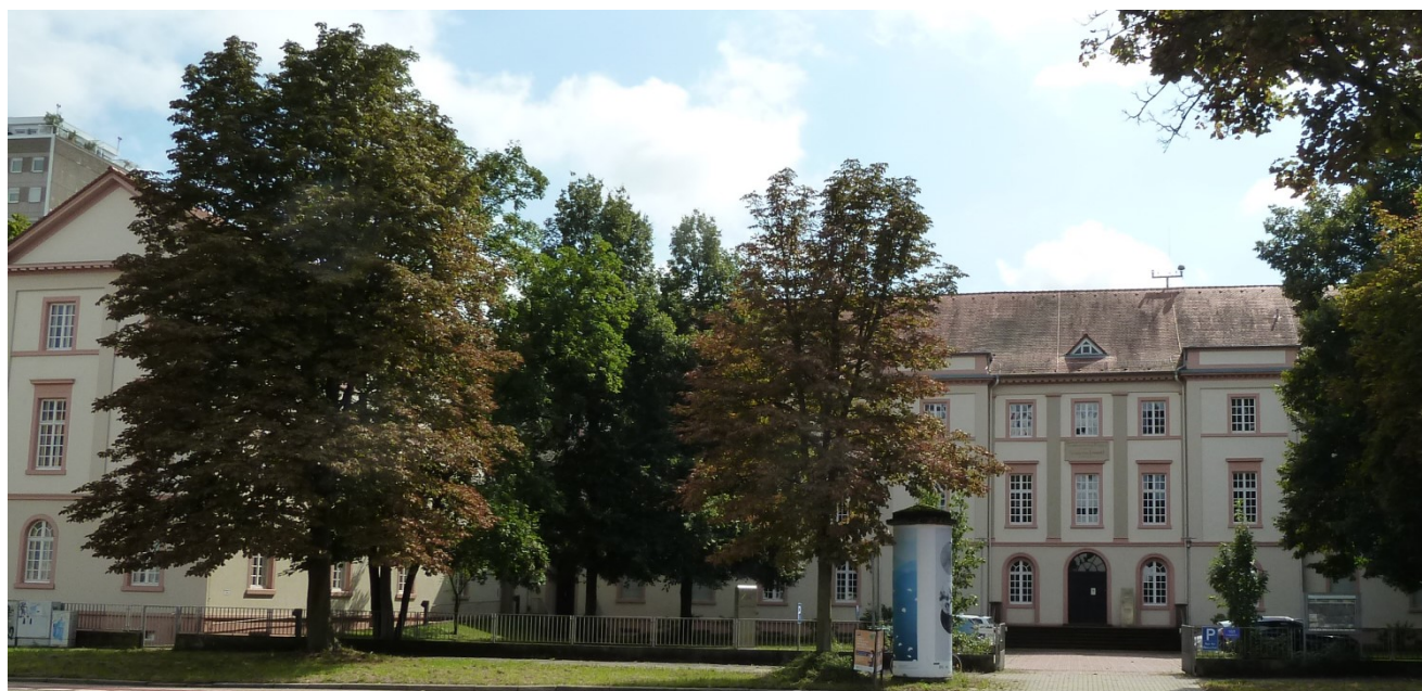
Abbildung 8: Kriegsstraße 103, Karlsruhe: bis 1945 Hauptversorgungsamt Südwestdeutschland, heute Landesamt für Geoinformation und Landentwicklung Baden-Württemberg, Dienststelle Karlsruhe
